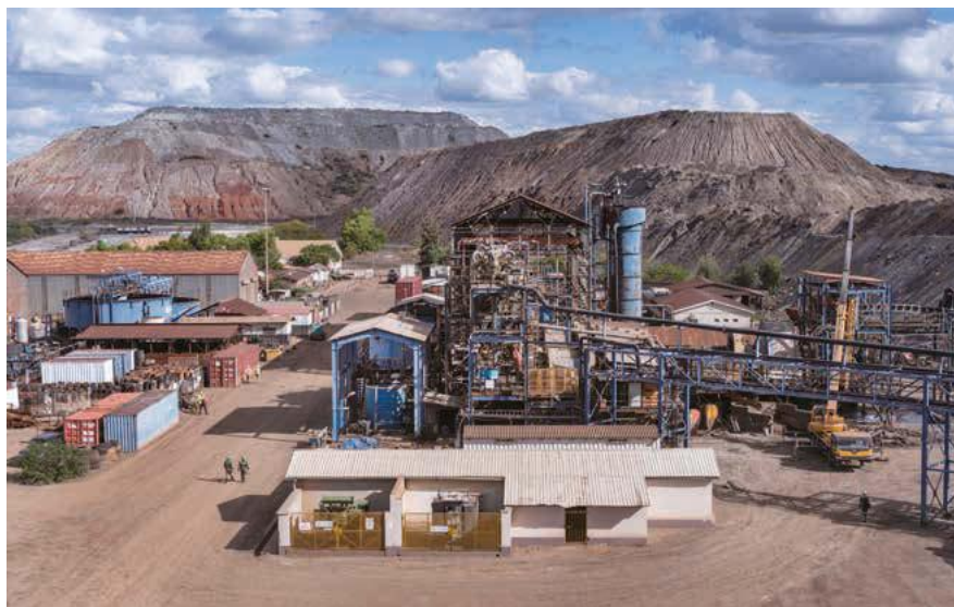
图表 19: Ruashi 铜钴矿现场情况
