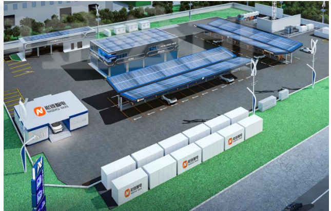
图表 30：能链智电光储充电站示意图
