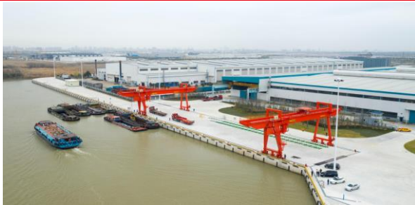
图：公司位于嘉兴的试运行码头
