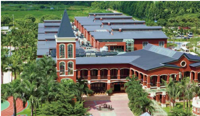
图 10：公司管理学校项目珠海容闲国际幼稚园
