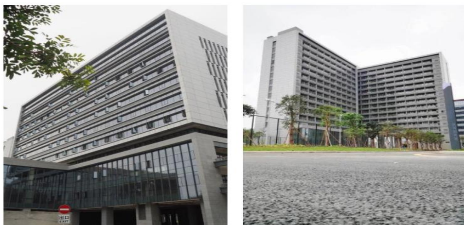
图 21：东莞生产基地一期项目
