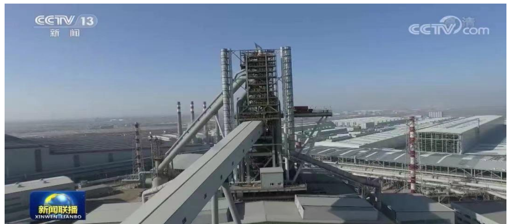
图 36：八一钢铁富氢碳循环高炉试验项目
